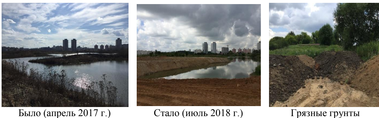
Рисунок 2 – Отсыпка береговой линии карьерного водоема
